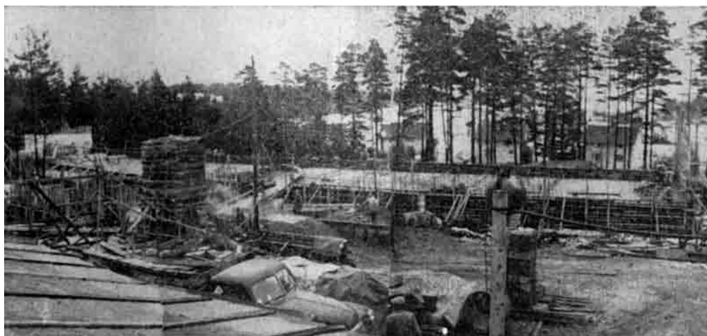
Pääskyvuoren koulurakennuksen rakennustyömaa 1960.
