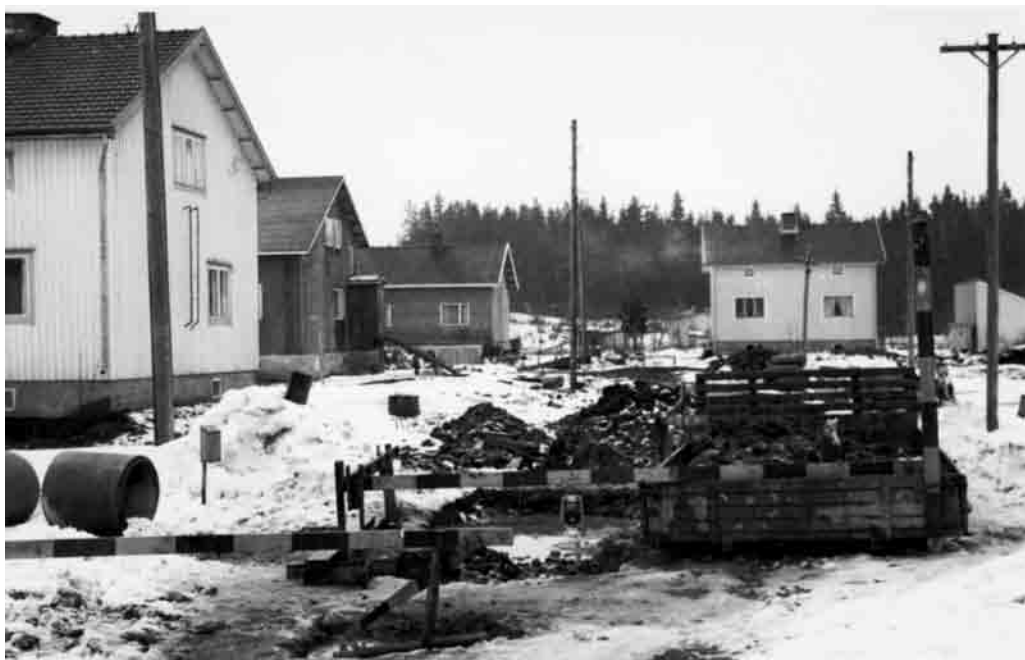
Pääskynvuoren kaupunginosan viemäriyöt käynnistyivät työllisyystöinä. Kuvassa osa viemäriyömaata
